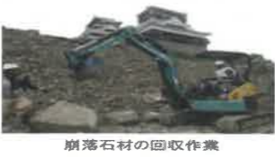
崩落石材の回収作業
