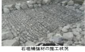
石垣補強材の施工状況
