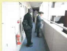
修繕工事後の定期点検
