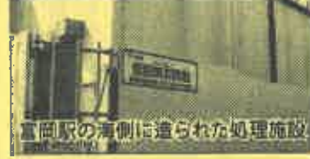
富岡町の海側に造られた処理施設
